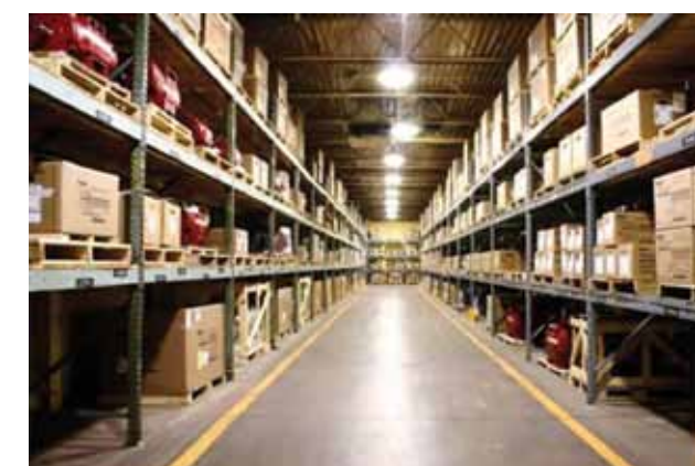
Figuur 1. In een magazijn is vooral licht in de gangpaden nodig en niet bovenop de stellingen.
